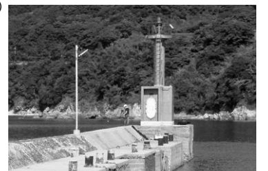
白井田港防波堤灯台(塗色:赤) 初点灯:昭和51年11月
