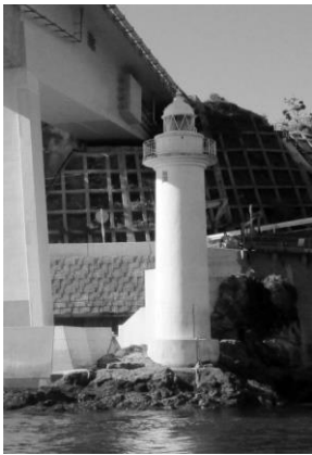
室津灯台(塗色:白) 初点灯:昭和11年6月 灯質: IsoWR6s (等明暗白赤光 明3秒暗3秒) 光達距離:12海里
