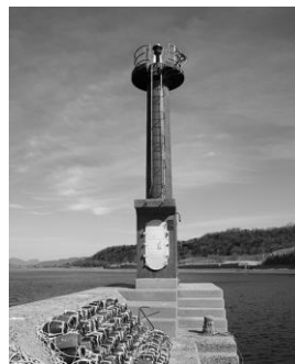
八島港防波堤灯台(塗色:赤) 初点灯:昭和46年9月
