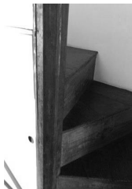
2階から4階までは芯柱を中心とした回り階段で昇っていきます
