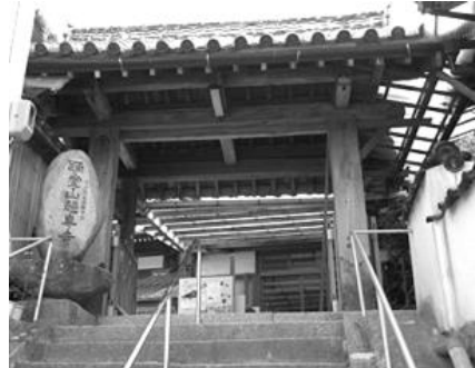
御茶屋の門を移築した超専寺の山門
