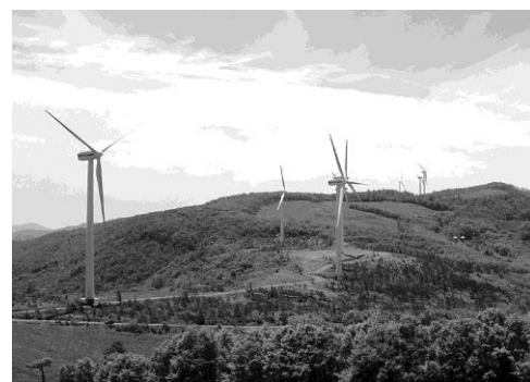
葛巻町の風力発電施設
